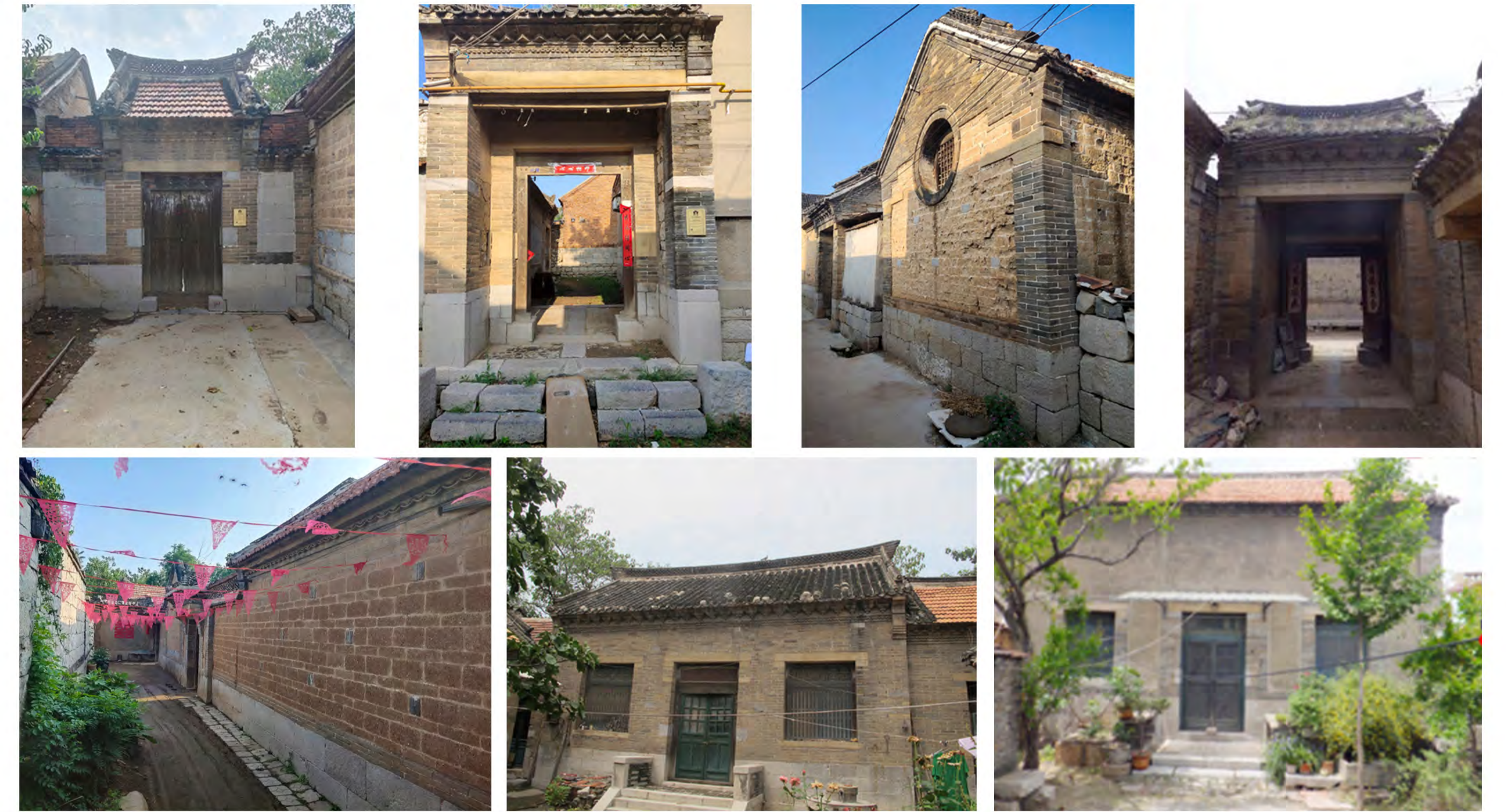
修缮类建筑（8处）
