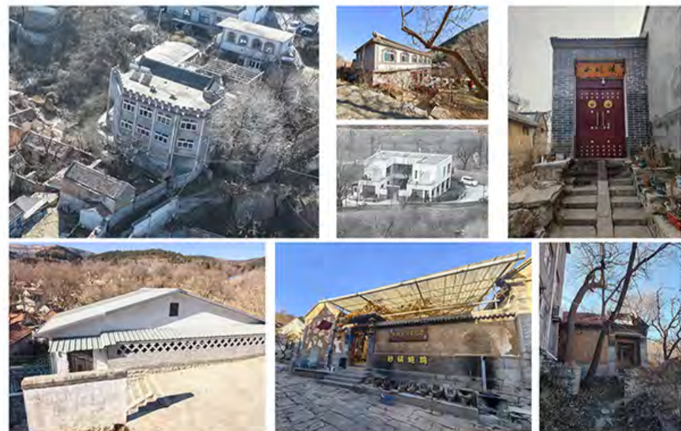
整治改造类建筑（80处）
